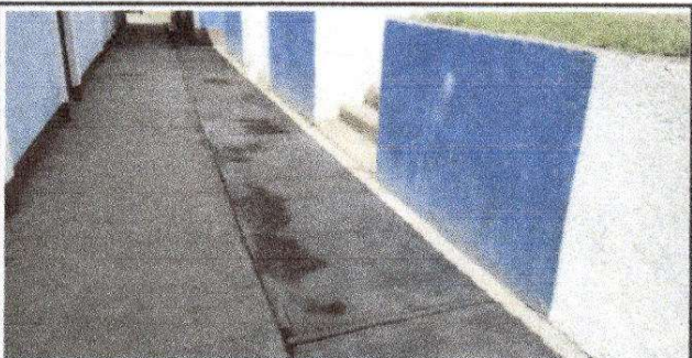
Foto 5: Piso de torta de concreto de 5cm de grosor instalado
